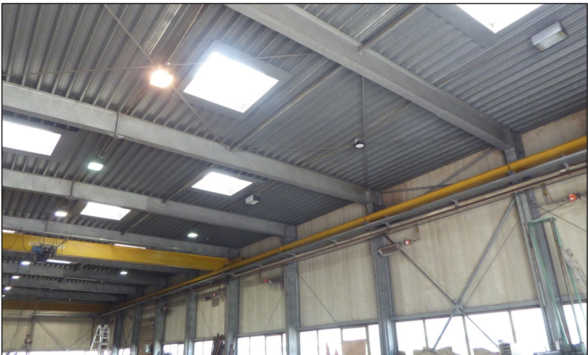
Abbildung 6: Ansicht einer neueren Halle (12.05.2022)
