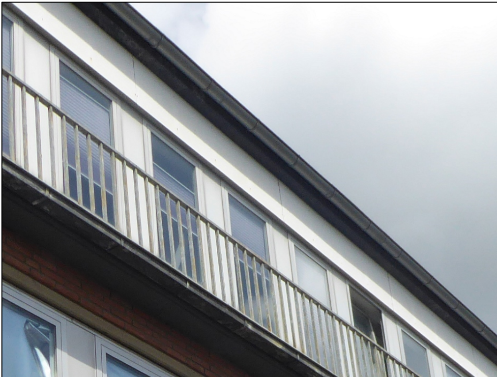
Abbildung 4: Beispiel des Dachübergangs beim Bürogebäude mit Verkleidung (12.05.2022)
