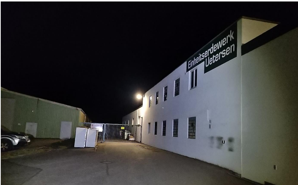
Abb. 1: Einfahrt zum Betriebsgelände des Einheitserdewerks in Uetersen.
