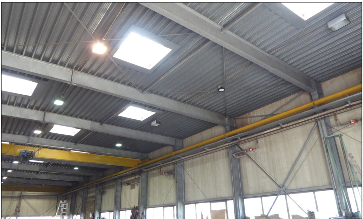
Abbildung 6: Ansicht einer neueren Halle (12.05.2022)
