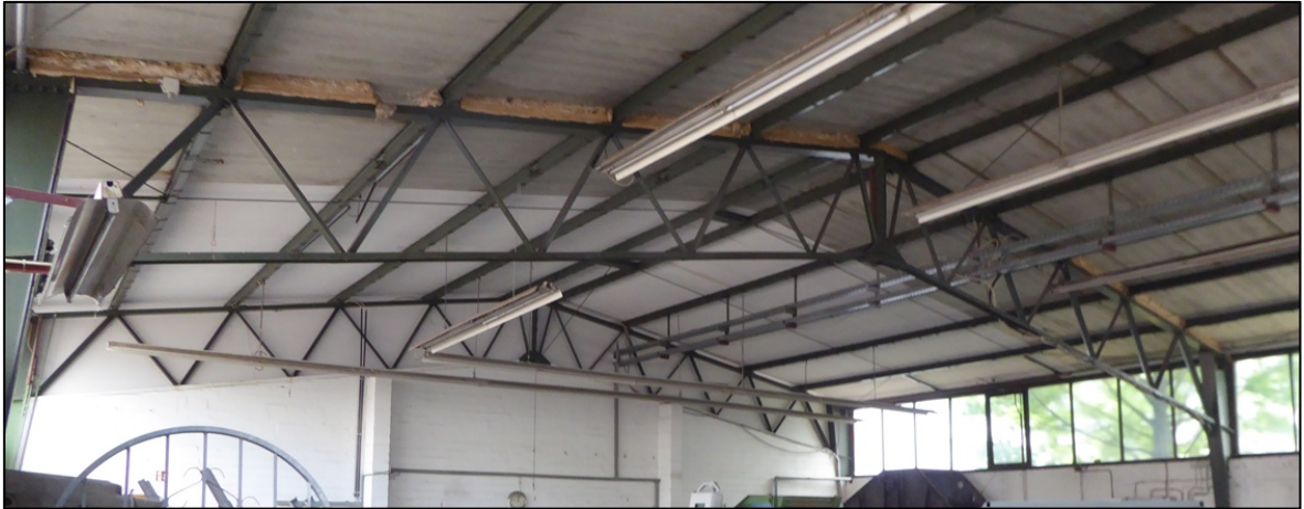
Abbildung 7: Ansicht einer älteren Halle (12.05.2022)
