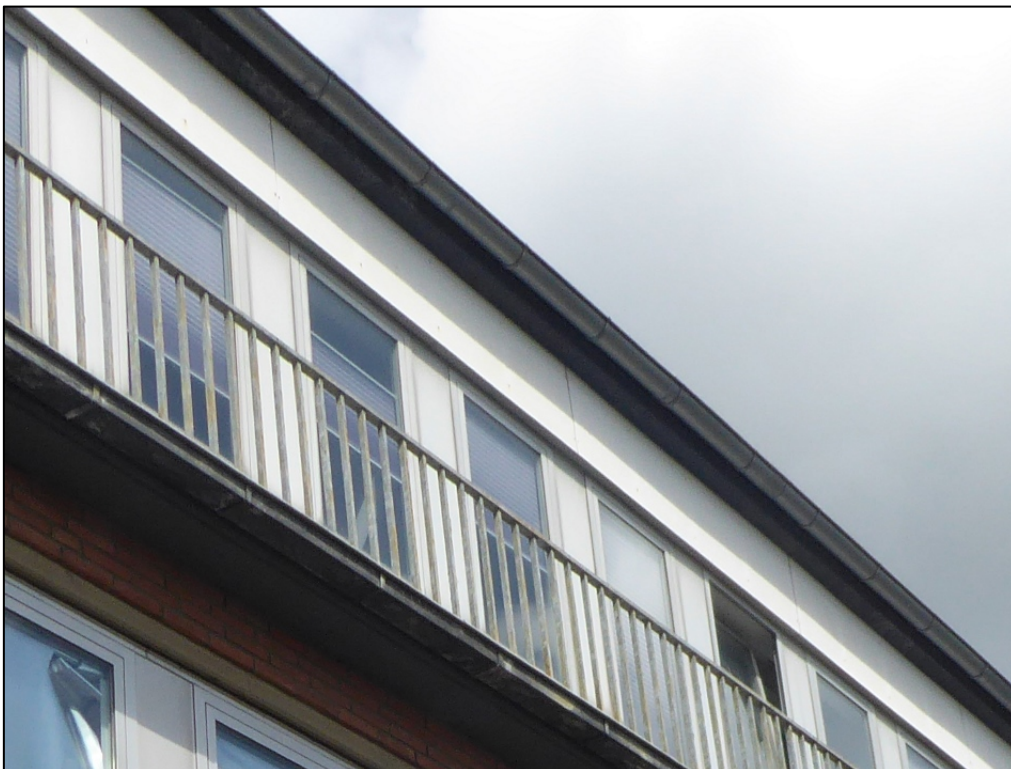
Abbildung 4: Beispiel des Dachübergangs beim Bürogebäude mit Verkleidung (12.05.2022)
